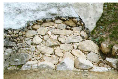
9面裏旧石垣 東西延長6.0m、高さ2.5mの範囲を検出。その勾配は46°と非常に緩く、石材には自然石のみを用いる。
