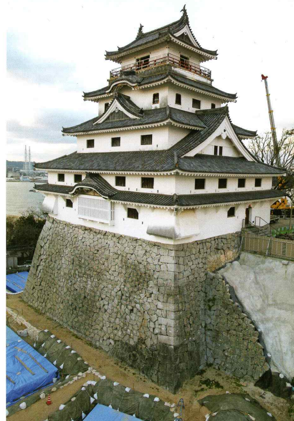
天守台石垣と現代の模擬天守 本丸南西部にある天守台石垣は、割石を用いた乱積みである。その上には、昭和41年にコンクリート製の模擬天守が建てられている。
