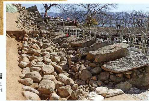
9面石垣裏の栗石層 大振りな栗石（左）と小振りな栗石（右）が使い分けられている。
