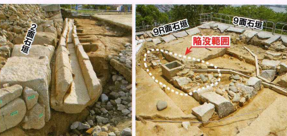
蛇行する石組溝 陥没した門櫓の櫓台北面石垣
