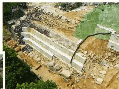
13面石垣裏のコンクリート擁壁 仮設のコンクリート擁壁は、石垣積み上げの際に全て撤去した。
