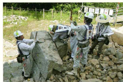
石垣解体作業の様子
