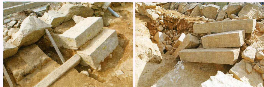
陥没した石垣と石段 (左:1面石垣裏、右:9面石垣裏) 1面石垣裏では、石垣石段が前へ、石段が後ろへ倒れている。9面石垣裏では、陥没穴へ向けて全ての石材が吸い込まれている。
