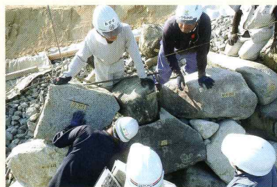
石垣積み上げ作業の様子
