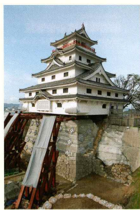
解体完了時の天守台石垣と天守閣建物
