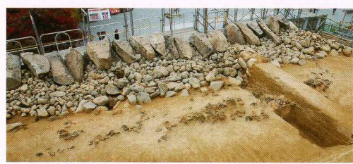
9面石垣裏の瓦堆積層
