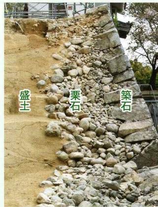
9面石垣裏の内部構造
