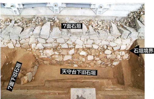
天守台下旧石垣 天守台(7面石垣)の直下で、東西延長8.3m、高さ1.5mの範囲を検出。さらに東でも検出しており、総延長は20m以上となる。その勾配は64°と緩く、石材には自然石のみを用いる。
