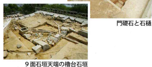
9面石垣天端の櫓台石垣
