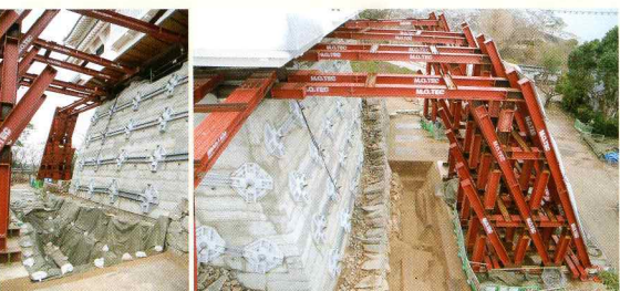
天守台石垣解体完了時の仮設トラス 天守台脇に仮設トラスを設け、天守閣建物の基礎杭にあてている。
