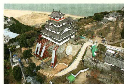
天守台へ繋がる仮設道路
