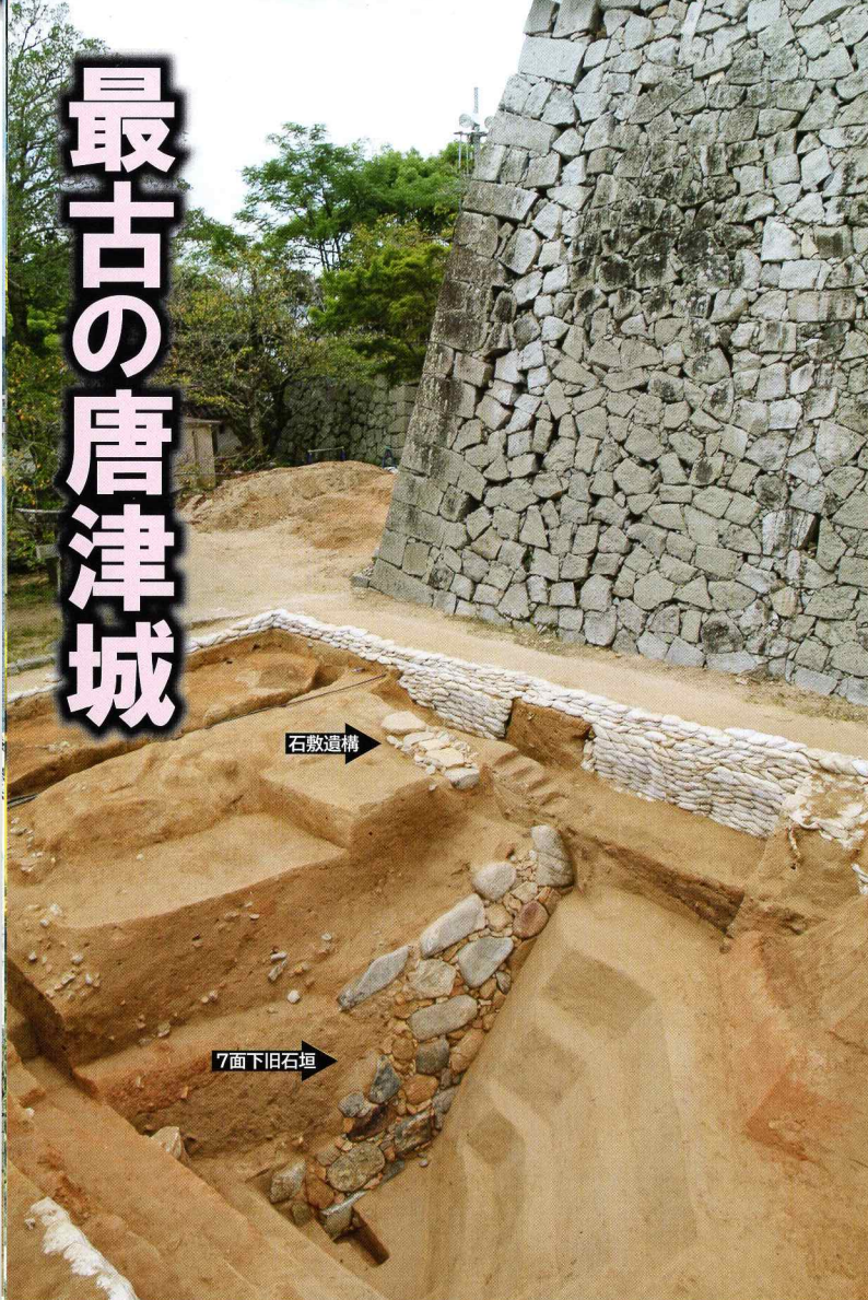
天守台(7面石垣)と埋没した7面下旧石垣 7面下旧石垣は高さ3.6m、南北延長8.7mを検出。その勾配は66°と緩く、自然石のみを用いる。旧石垣裏では、排水用石組溝の底石列からなる石敷遺構も検出した。
