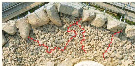
1・2面石垣隅角部裏の栗石 赤色破線の位置で、栗石の規格や形状、材質が変化する。
