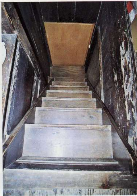
2 主屋中央にある階段を二階からみる
