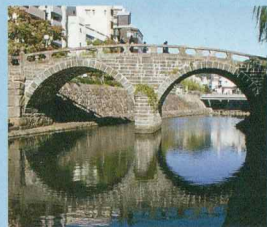
眼鏡橋 1634年に興福寺の熱心者によって架設された日本初の石造アーチ橋。国指定重要文化財。
