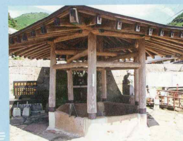
六角井戸 弘法大師が六角の杖で大地を突くと水が湧き出し、住民を水不足から救ったという伝説の井戸。別名「弘法大師お助けの井戸」。集落唯一の水場であり社交場でもありました。
