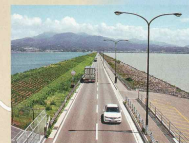
雲仙多良シーライン まっすぐに延びる約8kmの干拓堤防道路。中間地点に設置された展望歩道橋に立てば、両側に有明海といさはや新池(調整池)、前後に雲仙と多良の山々を眺めることができます。
